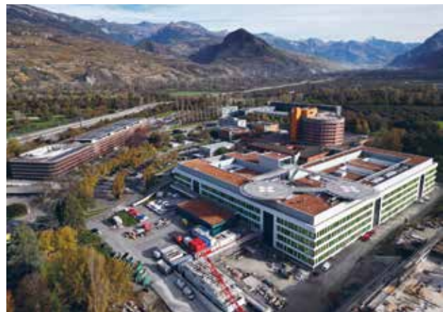
Chantier de Sion – 24.11.2024
