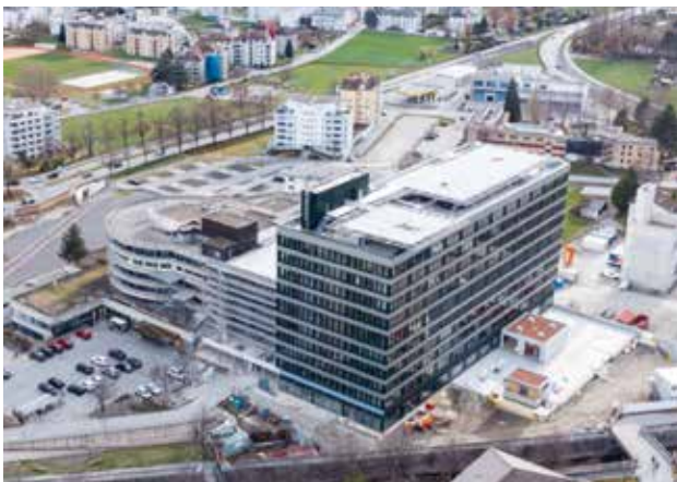
Chantier de Brigue – 13.03.2026
