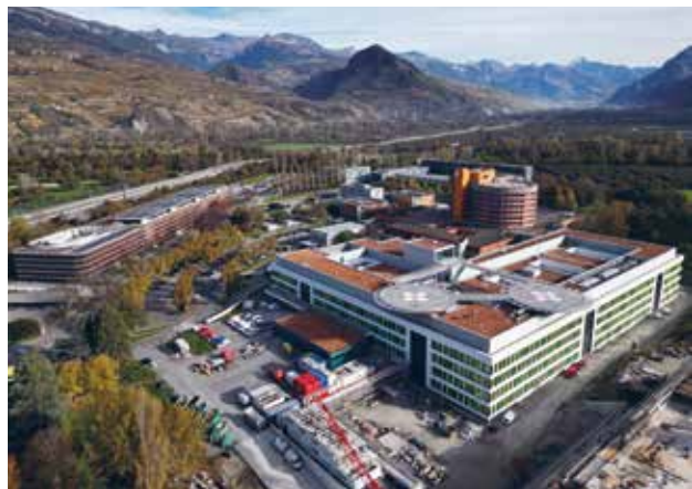
Baustelle in Sitten – 24.11.2024
