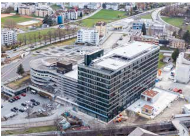
Chantier de Brigue – 13.03.2026
