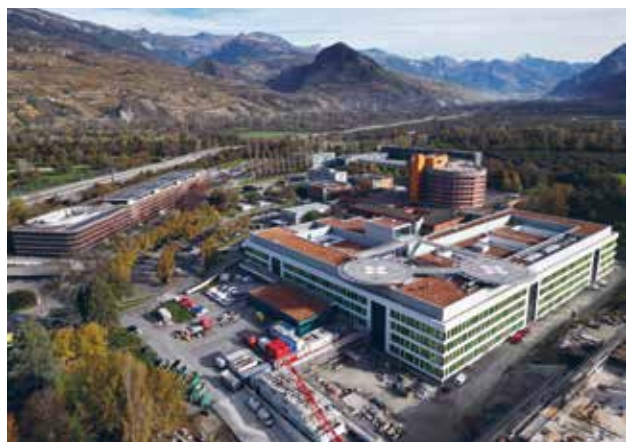
Chantier de Sion – 24.11.2024
