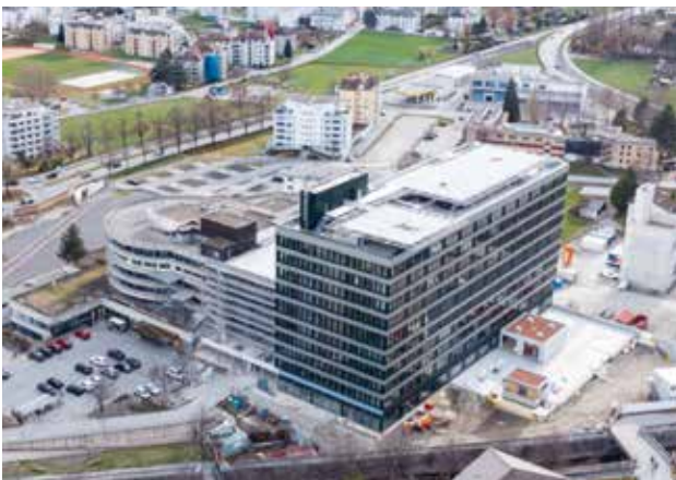
Baustelle in Brig – 13.03.2026
