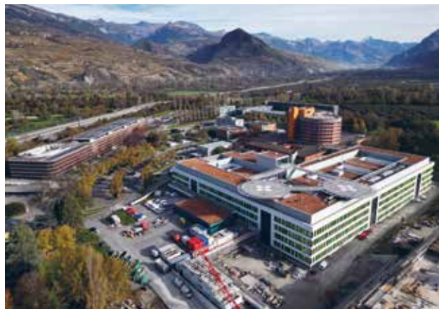
Baustelle in Sitten – 24.11.2024
