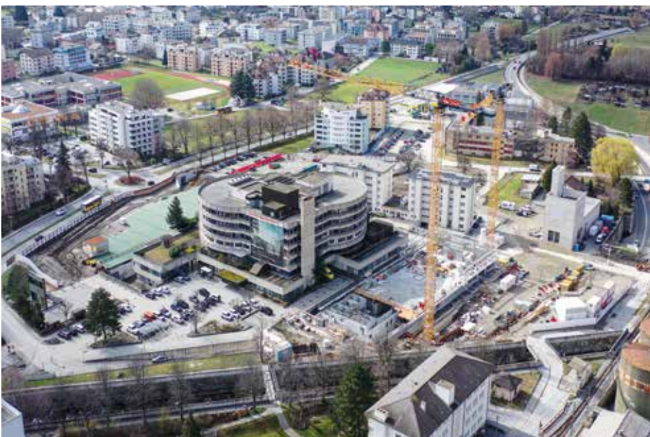
Baustelle in Brig – 18.12.2023
