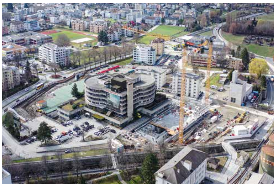
Chantier de Brigue – 18.12.2023
