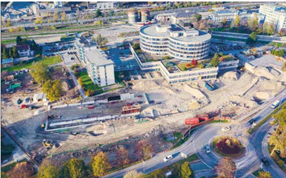
Baustelle des Parkhauses in Brig – 15.11.2022
